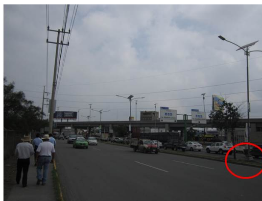
Arbotantes instalados en la Avenida Ruiz Cortines, como referencia para destacar la diferencia entre el tipo de bases, las aquí presentadas, pagadas mediante la obra en estudio con las localizadas en el cruce de la citada Avenida con las Avenidas Pedro Infante y Seguridad Social.
