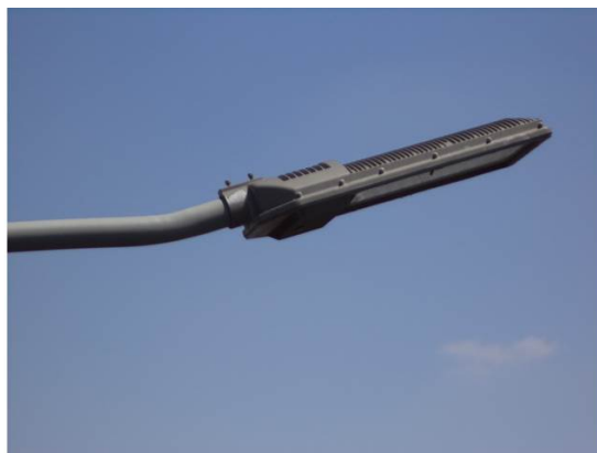
Luminarias localizadas en las cuales no se observa el Gabinete tipo módulo inversor ni la fuente de poder.
