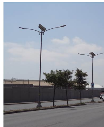
Luminarias localizadas en las cuales no se observa el Gabinete tipo módulo inversor ni la fuente de poder.
